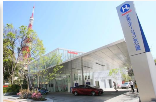
水素を補給するための水素ステーション
