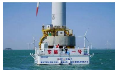
浮揚式洋上水素製造プラットフォーム「東福1号」/CROnlineより
